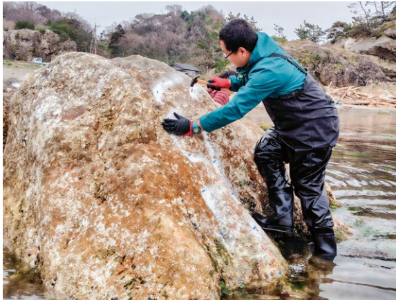
図5 岩にアンカーを打ち込む様子（2025年4月撮影）
