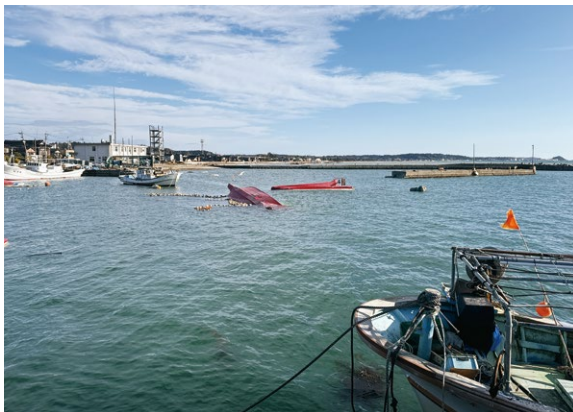
図10 飯田港の津波被害状況 (2024年1月5日撮影)
