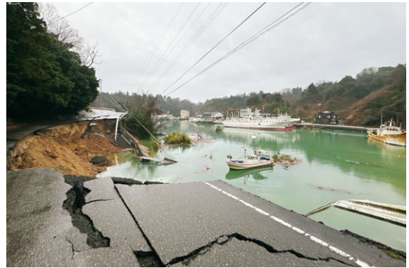
図7 九十九湾沿いの道路・係留岸壁崩落（能登町おぎ小木地区）（2024年1月3日撮影）
