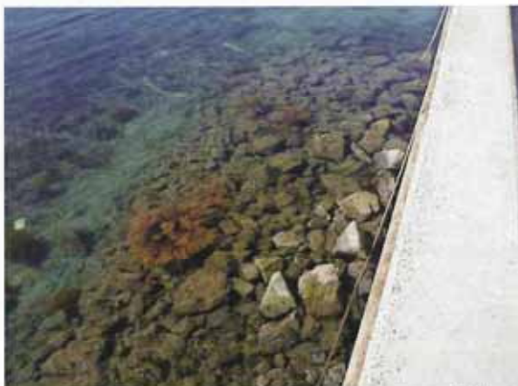
写真1 穴水町新崎の人工海岸に投入された自然石
