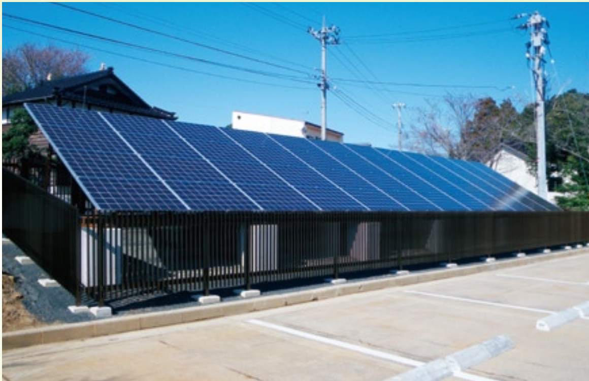
のと海洋ふれあいセンター省エネ改修 かいしゅう 工事で設置された太陽光発電 たいようこうはつでん パネル(6ページ参照)
