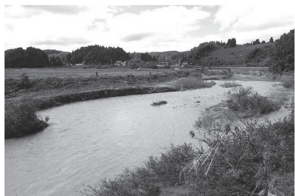
図 7 豪雨直後の町野川 (M7 よりも上流、撮影日:2024 年 10 月 5 日)
